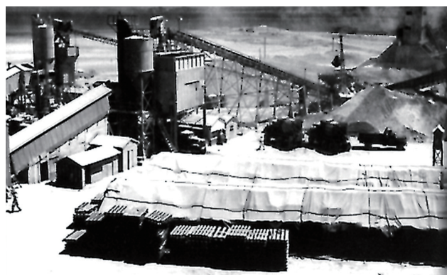
図4 沖縄・牧港のバッチャープラント(清水建設提供)
