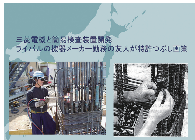
図2 鉄筋リブからのガス圧接の超音波探傷試験 (社)鉄筋継手協会提供)
