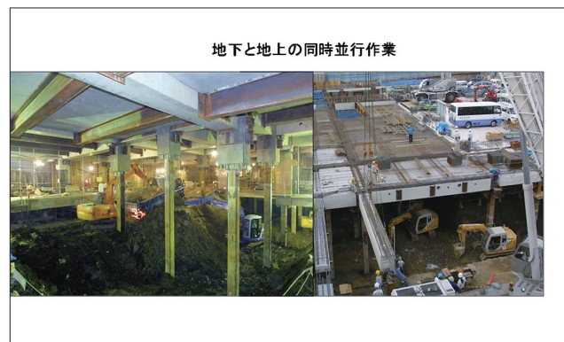
図12 新地下工法(清水建設提供)
