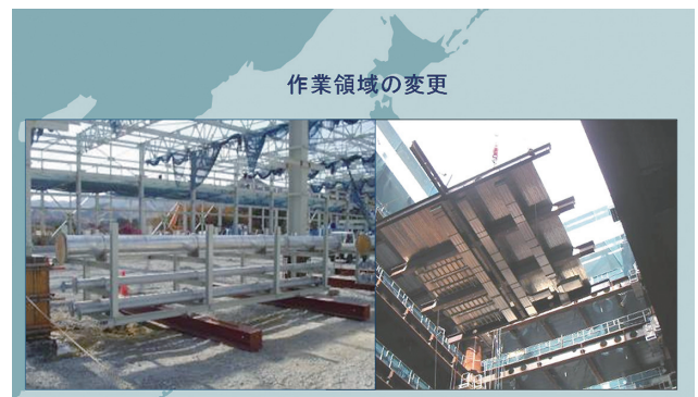
図10 設備一体化工法(清水建設提供)
