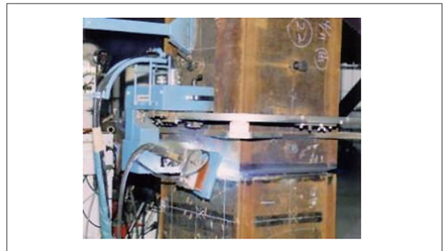
図33 柱-柱接合部の自動溶接(清水建設提供、溶接学会賞)
