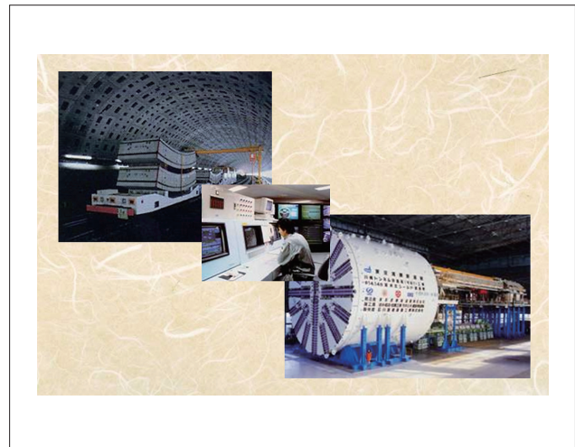
図41 自動化で大きな成果を出したシールドトンネル (清水建設提供)
