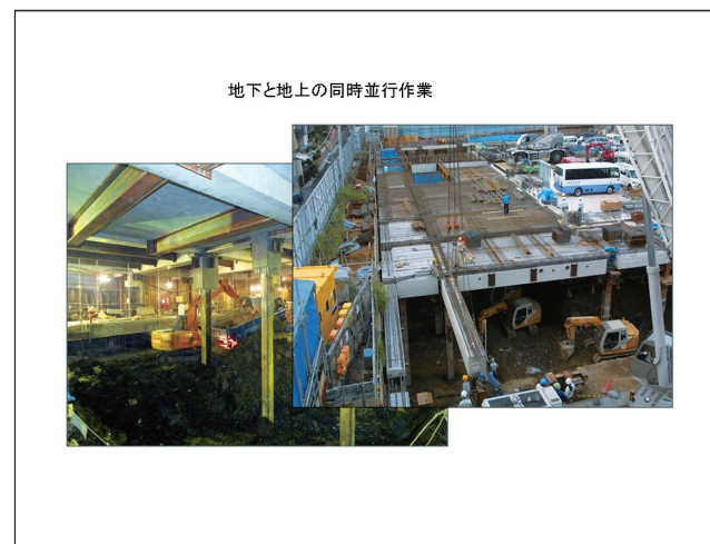
図17 地下工法は今でも工夫の余地がある(清水建設提供)
