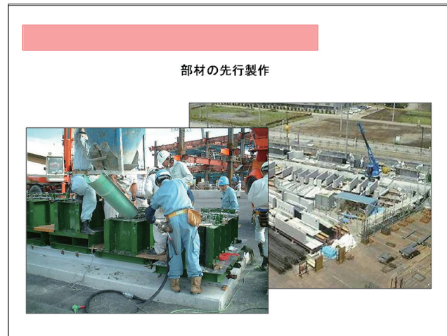
図18 サイトPCa工法(清水建設提供)
