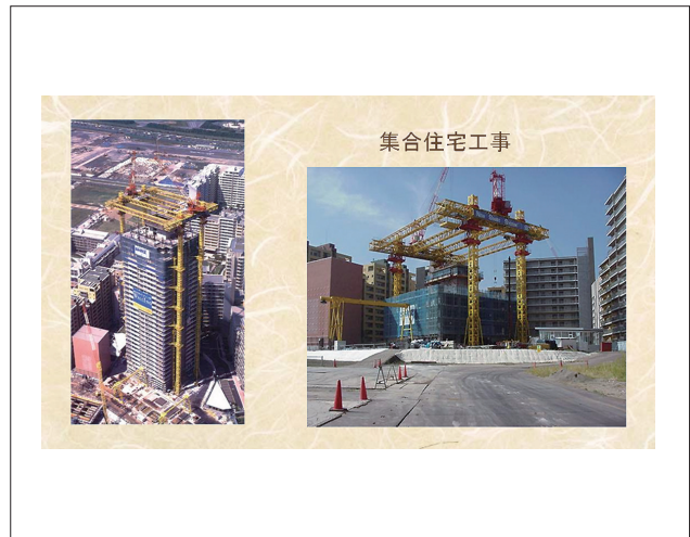
図44 既存技術・仮設と融合した自動施工システム思想 (清水建設提供)
