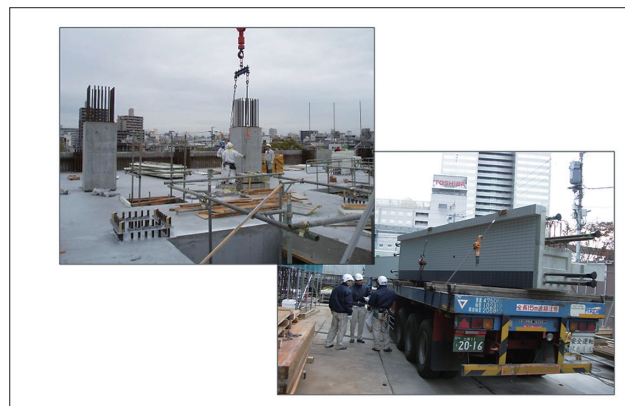
図12 Pca工法によるコスト低減と短工期化(清水建設提供)
