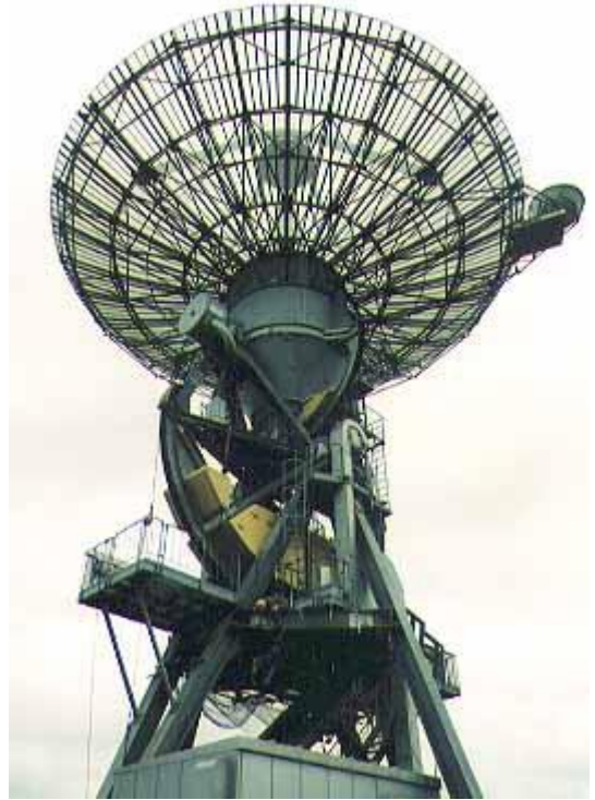
写真2：勝浦市 宇宙開発事業団 衛星追跡 所の136/400MHz帯アンテナ、直径 18m
