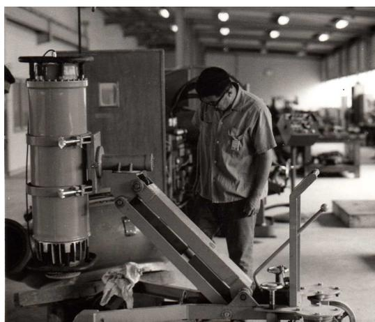
写真1 昭和44年の私と鑄鋼のX線撮影初期の300KVの管球で約60kgあり、取外し作業は大変でした。脇に立っている私と比較してみてください。
