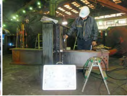
工場溶接(パス間温度測定中)
