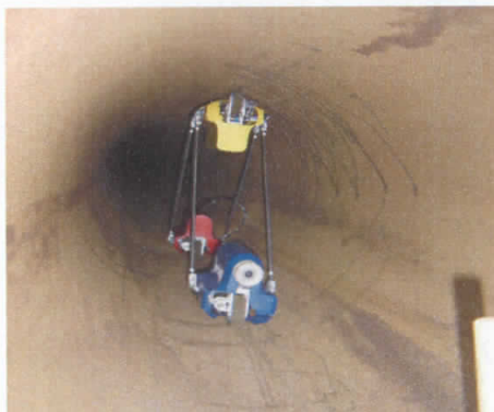
(a) 水平部走行状況
