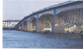
鋼橋(主に道路橋)
